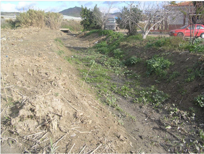
F2 Sección cauce aguas arriba
