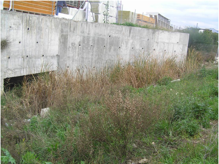
F4 Sección cauce aguas abajo
