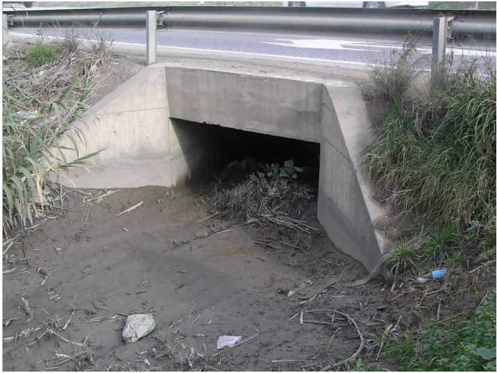
F3 Sección obra de drenaje transversal aguas abajo
