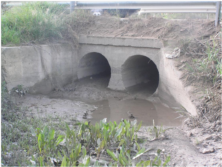
F1 Sección obra de drenaje transversal aguas arriba
